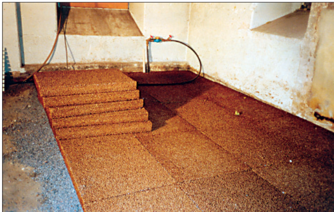
Lämmöneristys, salaojitus ja kapillaarikatko
